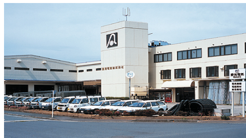
小田原本社ビル
