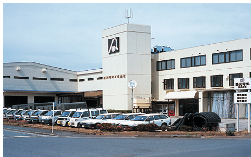
小田原本社ビル
