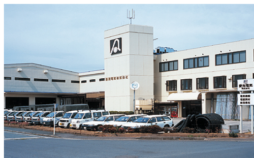
小田原本社ビル
