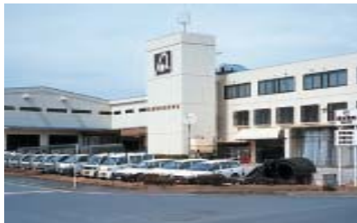
小田原本社ビル
